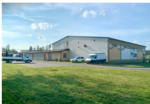
Pohled na budovu skladovací haly, parkovací plochy v areálu
