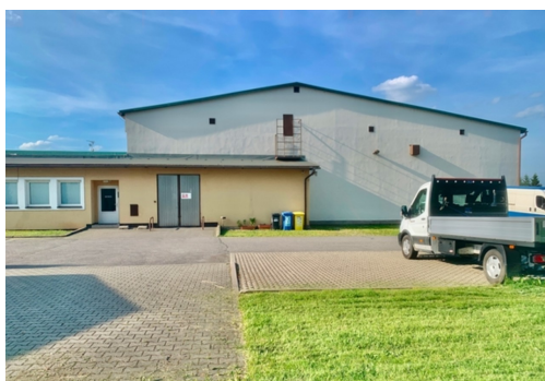
Pohled na J stranu skladovací haly, zásobovací/expediční vrata na úrovni terenu
