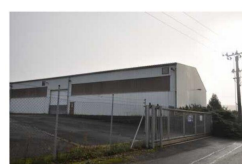
Výrobní a skladové haly č.p. 8 na pozemku parc. č. st. 108
