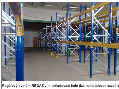
Regálový systém REGAZ v hl. skladovací hale ( lze nainstalovat i:azpět)
