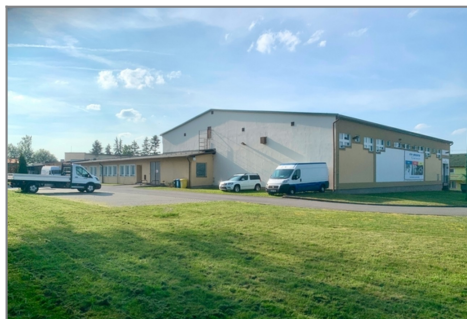
Pohled na budovu skladovací haly, parkovací plochy v areálu
