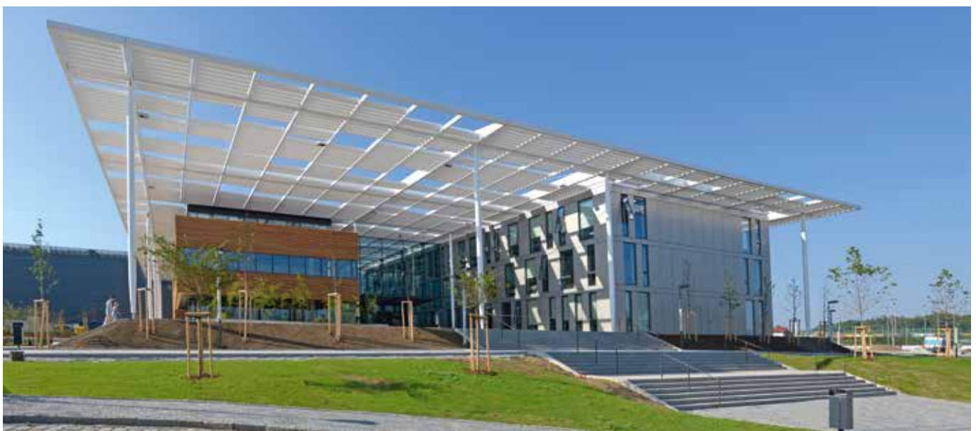
Centrum ELI BEAMLINES (Extreme Light Infrastructure) v Dolních Břežanech u Prahy je součástí výzkumné infrastruktury složené ze tří laserových center, která se vzájemně doplňují. Všechna centra slouží ke zkoumání interakcí laserových pulsů s hmotou, přičemž další dvě se nacházejí v Maďarsku a v Rumunsku
