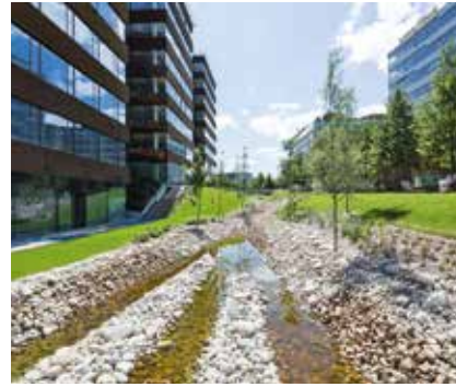
Retenční nádrž budovy Delta v BB Centru je symbolicky komponována do podoby říční delty a odkazuje tak na pojmenování projektu. Valouny vysypaná, uprostřed trávy a stromů působí i jako estetický prvek celého administrativního komplexu.
