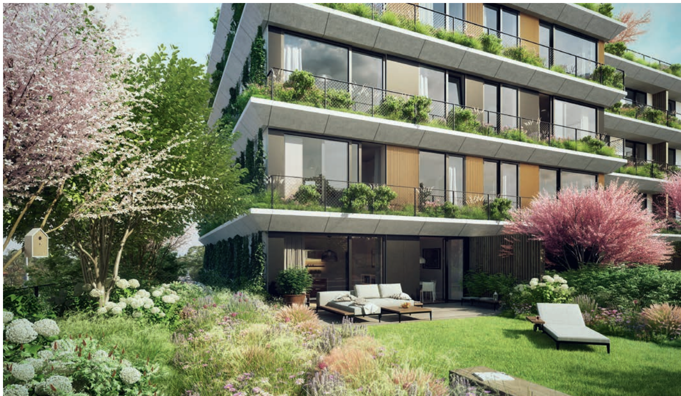
Sakura – nejzelenější český rezidenční projekt bude v pražských Košířích dokončen již v závěru letošního léta. Vhodná skladba vegetace a řešení zavlažování bylo výzvou pro zahradní atelier Flera (T.E)
