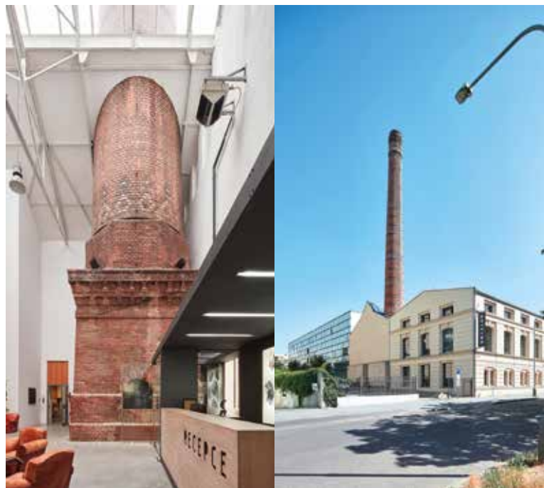
Kotelna v Pernerově ulici
