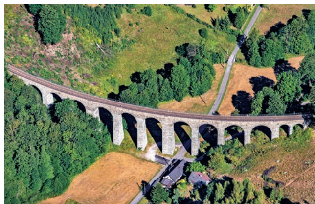
Novinský železniční viadukt z Kryštofova Údolí ohromuje svou přibližně devětadvacetimetrovou výškou
