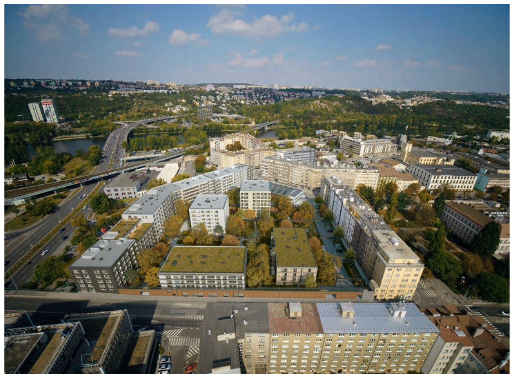
Lokalita, v níž v pražských Holešovicích vznikne Rezidence Pergamenka (FINEP)
